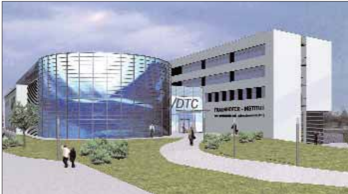
So soll das VDTC, der Erweiterungsbau des Fraunhofer IFF aussehen. Die Fertigstellung ist für 2006 vorgesehen.
