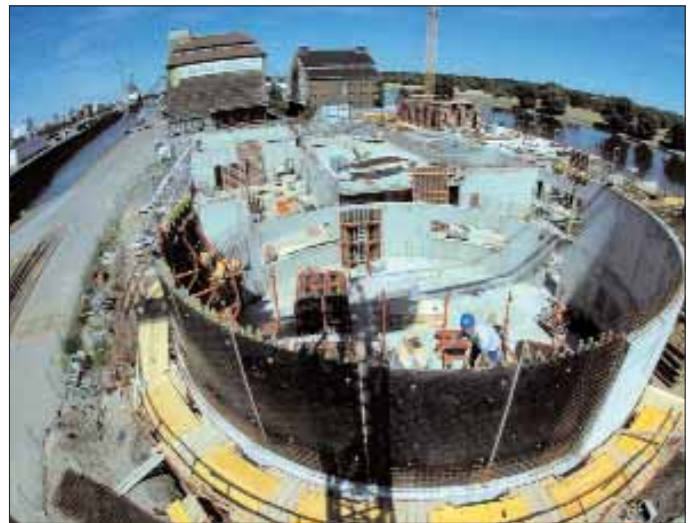
Schon jetzt gut sichtbar ist das kreisrunde Virtual-Reality-Technikum, das mit einem Durchmesser von 18 Metern die gewölbte Projektionsfläche beherbergt.
