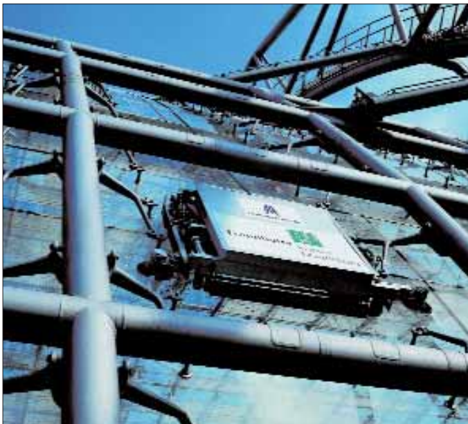
Innovation durch Automatisierung: Das weltweit erste vollautomatische Glasfassadenreinigungssystem für gewölbte Flächen - entwickelt von Spezialisten am Magdeburger Fraunhofer IFF.
