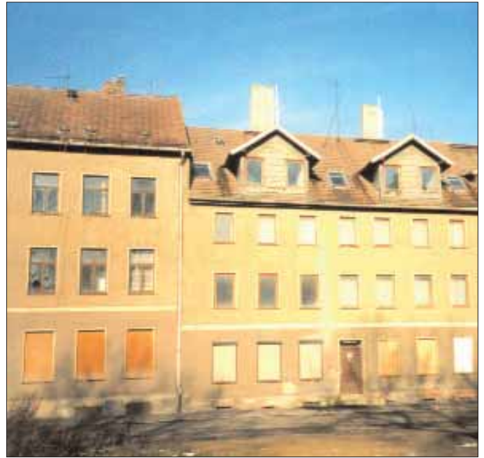
In diesem alten, unsanierten Haus in der Martinstr.10 beginnt die Geschichte des Fraunhofer IFF. In dem provisorischen Sitz, nicht mehr als ein Notquartier im Magdeburger Stadtteil Buckau, nimmt eine erfolgreiche Entwicklung Ihren Anfang.
